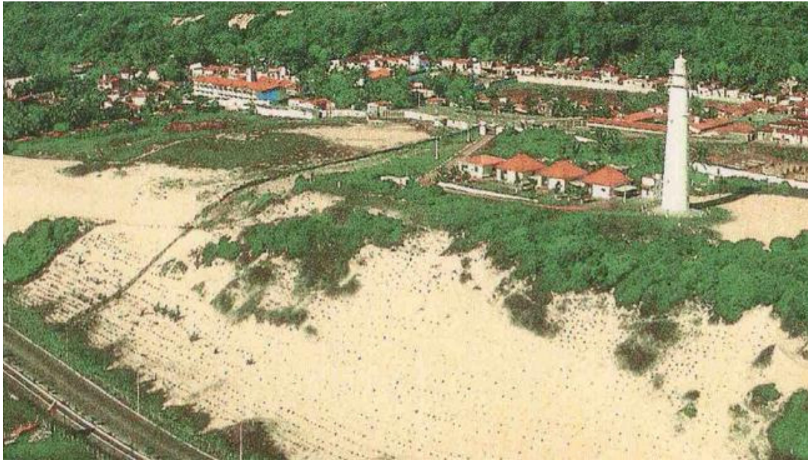
Ilustração n. Revegetação do talude para estabilizar a duna frontal ante a ação abrasiva dos ventos, com flagrante intervenção antrópica sobre a duna móvel. Anos 90.
