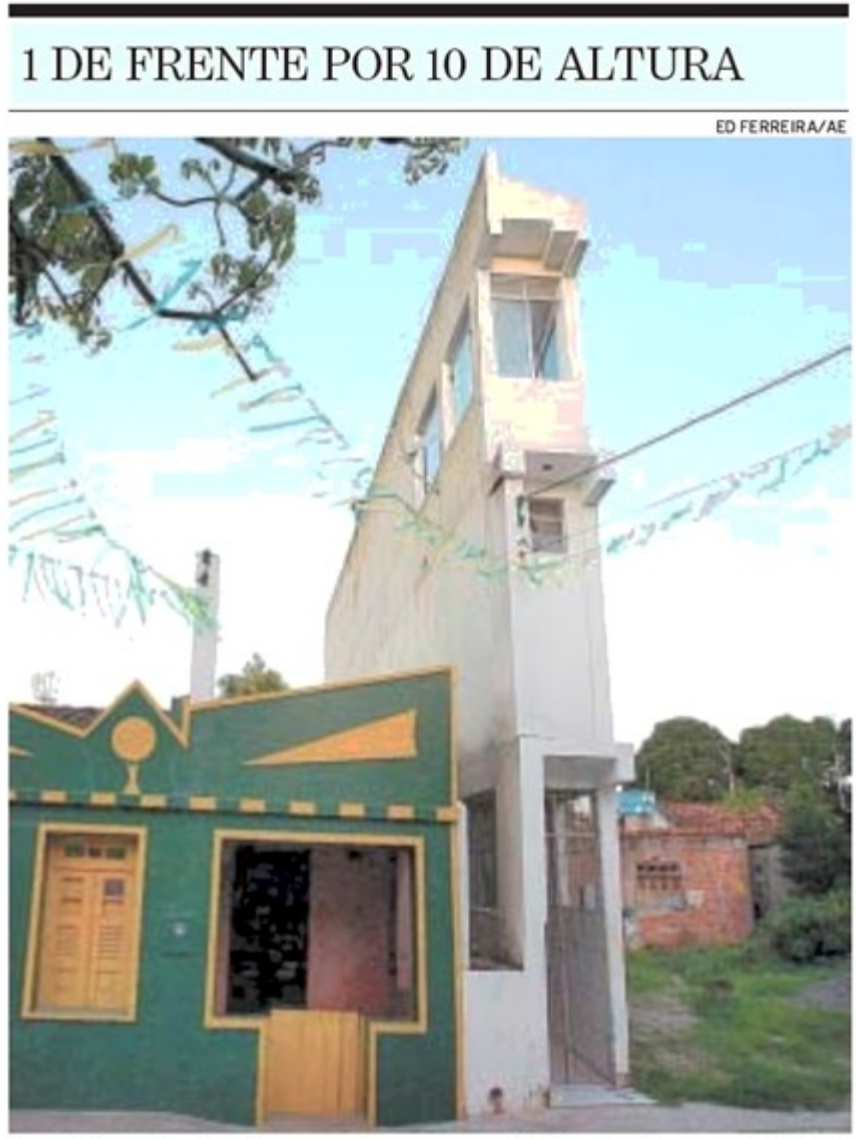
Um sobrado chama a atenção em Madre de Deus, na Bahia: tem 3 andares e nem o pedreiro pôs fé no que construiu ● PÁG. C8
