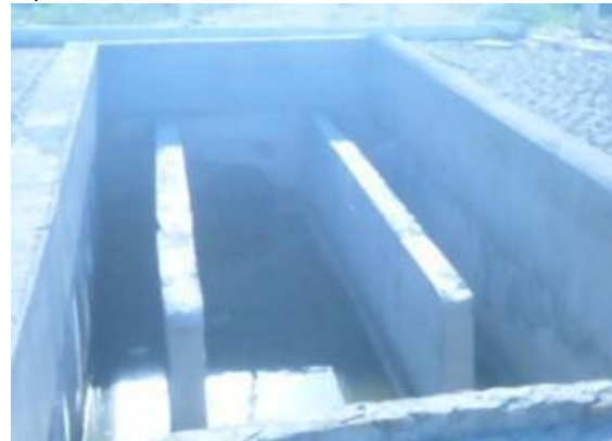
Figura 41. Vista da implantação de estação elevatória na área na qual outrora estava instalado o pré-tratamento da ETE Quintas I
