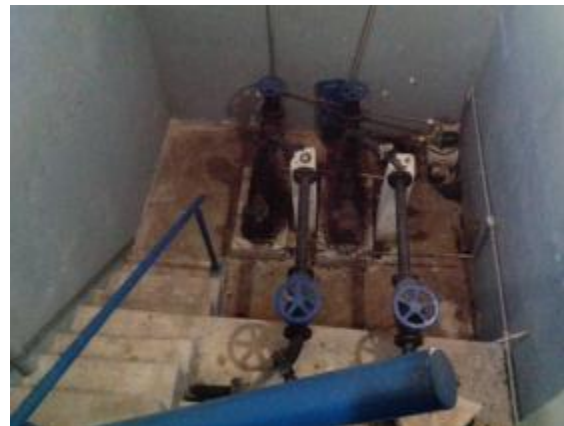
Figura 17. Vista das bombas centrífugas da elevatória EE03-GS
