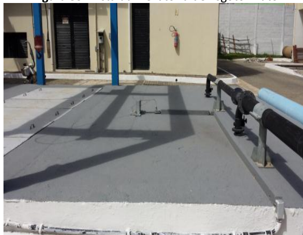
Figura 59. Vista da Elevatória de Esgoto Bruto
