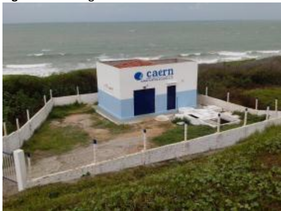
Figura 28. Vista geral da elevatória EEVC-03
