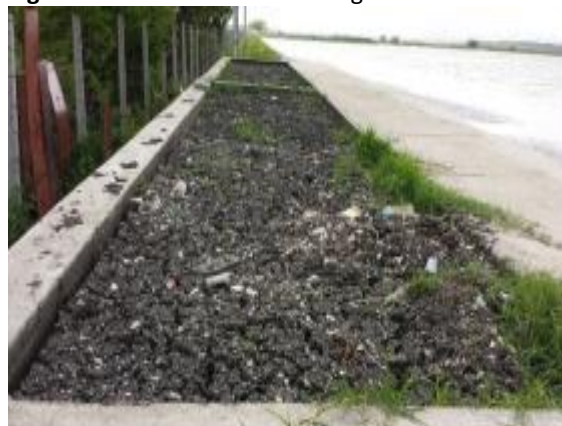
Figura 72. Vista do leito de secagem da ETE Beira Rio
