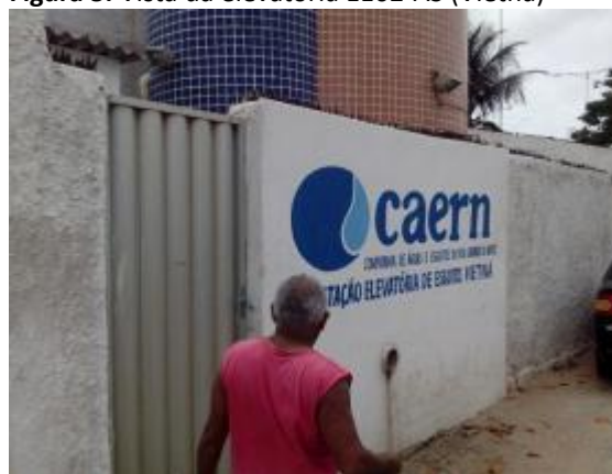
Figura 5. Vista da elevatória EE02-AS (Vietnã)
