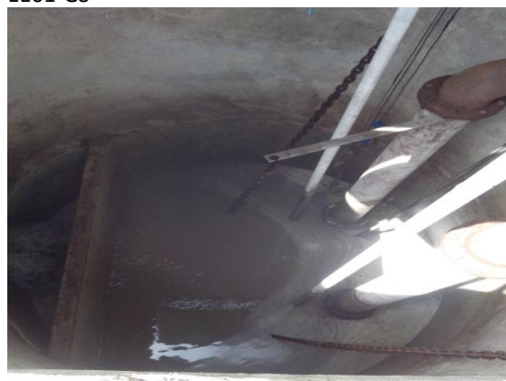
Figura 11. Vista do poço de sucção da elevatória da EE01-GS
