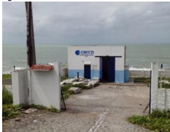
Figura 29. Vista frontal da elevatória EEVC-04
