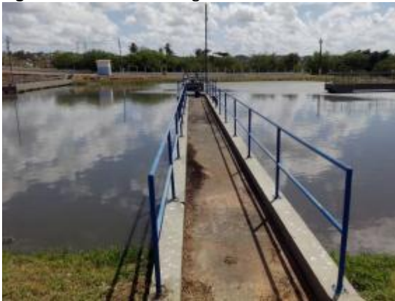
Figura 52. Vista da ETE lagoa aerada
