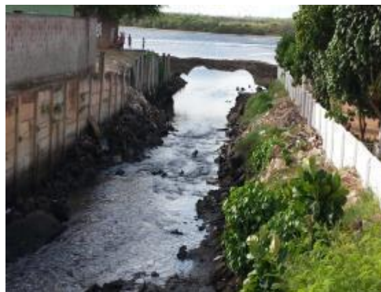
Figura 78. Vista da confluência entre o canal do Baldo e o estuário do Potengi
