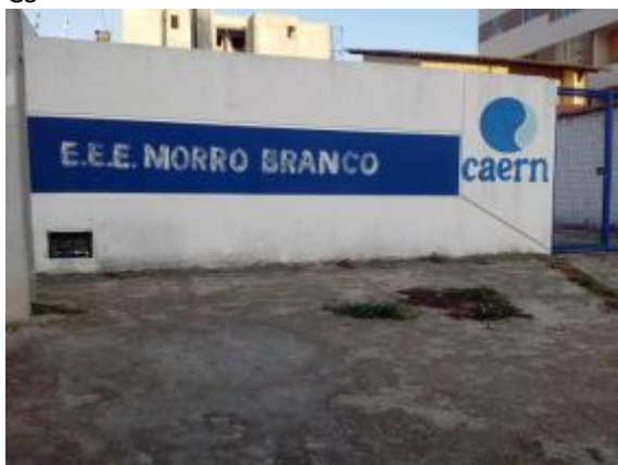
Figura 10. Vista frontal da estação elevatória EE01-GS
