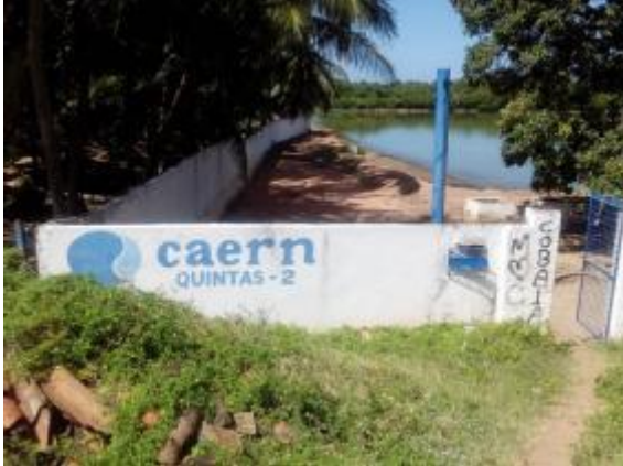
Figura 42. Vista da entrada da ETE Quintas II
