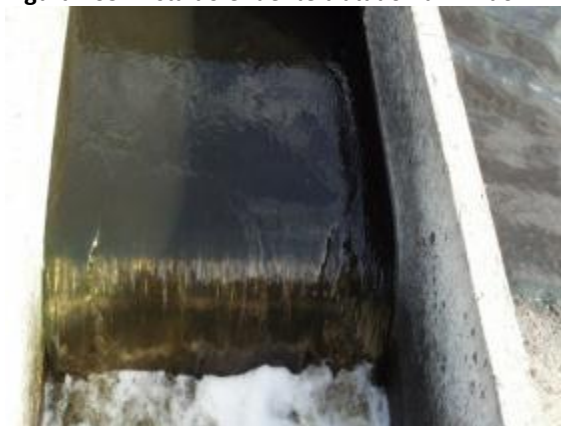
Figura 103. Vista do efluente tratado na ETE do DIN
