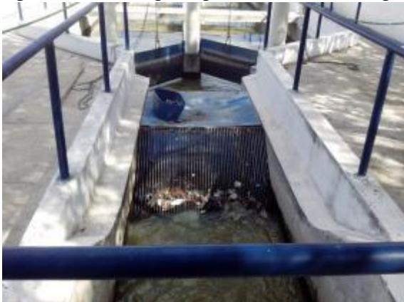
Figura 34. Vista da grade grossa da ETE Ponta Negra
