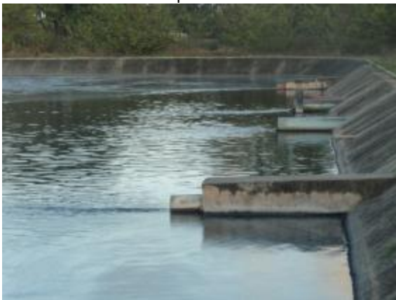
Figura 75. Vista da entrada de efluente na lagoa aerada de mistura completa
