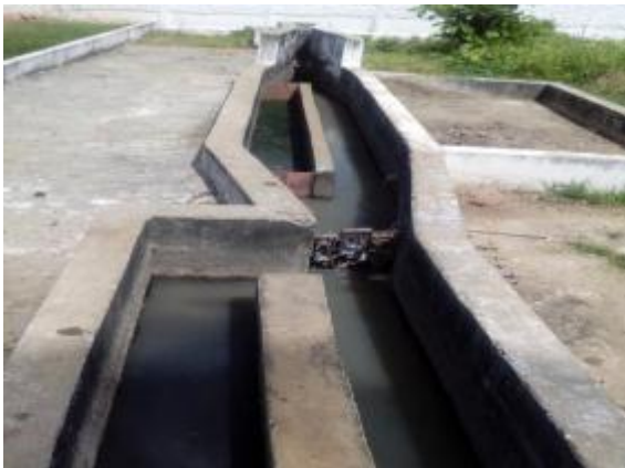
Figura 44. Vista das unidades de pré-tratamento ETE Quintas II
