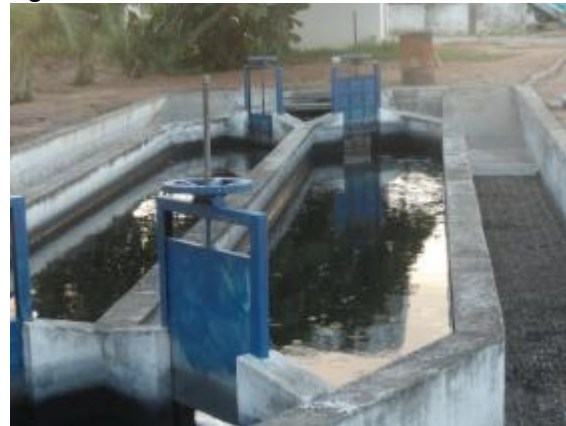
Figura 74. Vista do Pré-tratamento do SITEL do DIN
