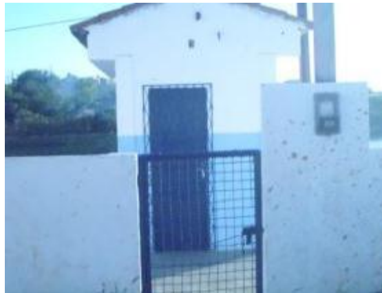
Figura 49. Vista da sala do operador da ETE Bairro Nordeste
