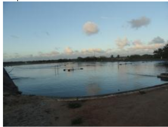
Figura 76. Vista da lagoa aerada de mistura completa do SITEL do DIN
