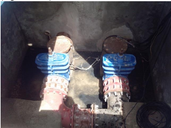
Figura 22. Vista do barrilete da elevatória EE03-HS (Lagoa do Preá)
