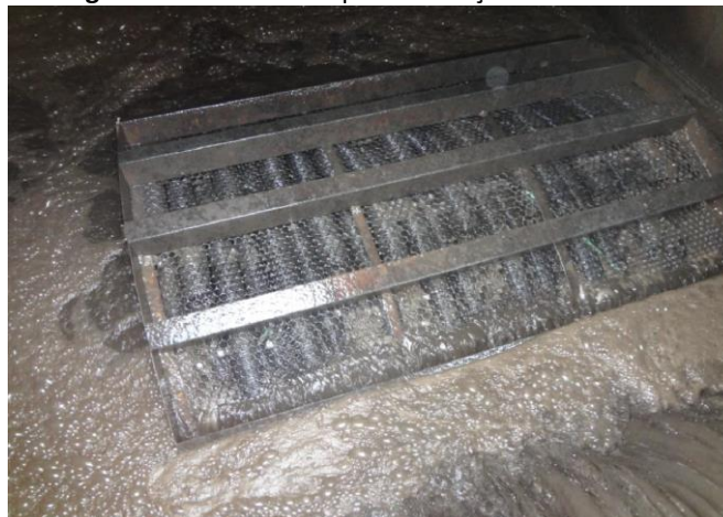
Figura 65. Vista do tanque de aeração com biodisco
