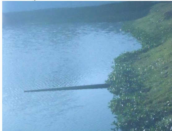
Figura 51. Vista da entrada de esgotos na lagoa de estabilização da ETE Bairro Nordeste
