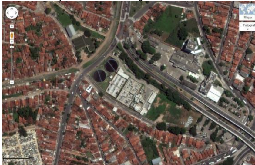
Figura 56. Vista aérea da Estação de Tratamento de Esgotos do Baldo e área circunvizinha
