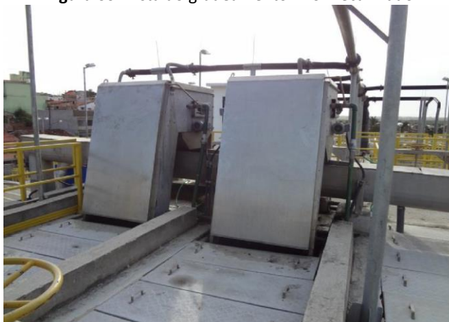
Figura 60. Vista do gradeamento fino mecanizado
