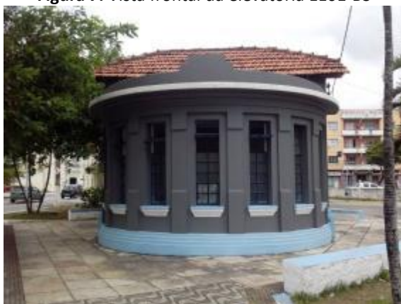
Figura 7. Vista frontal da elevatória EE01-B
