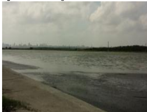
Figura 70. Vista da lagoa facultativa da ETE Beira Rio
