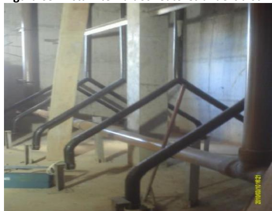
Figura 63. Vista interna dos reatores anaeróbios
