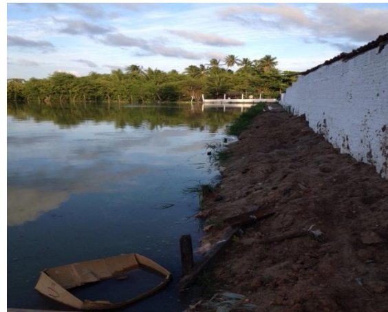
Figura 47. Vista da lagoa de estabilização da ETE Quintas II
