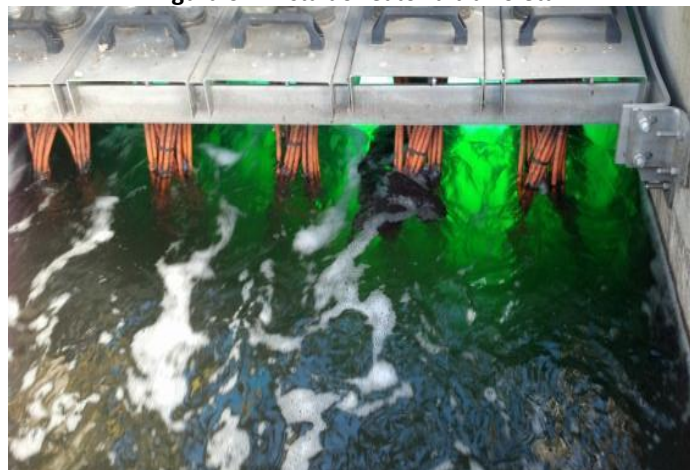
Figura 67. Vista do reator ultravioleta
