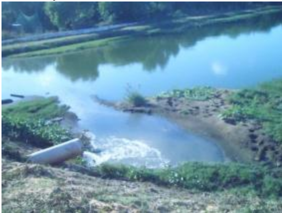
Figura 40. Vista de assoreamento na lagoa de estabilização da ETE Quintas I
