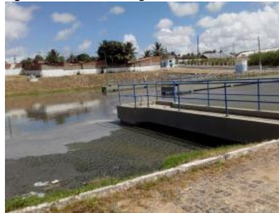
Figura 53. Vista da ETE lagoa aerada
