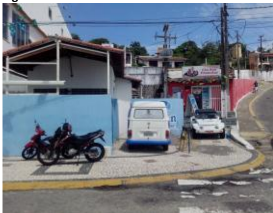
Figura 30. Vista da elevatória EE01-NS
