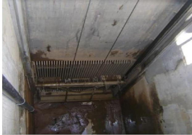
Figura 58. Vista do gradeamento grosseiro mecanizado
