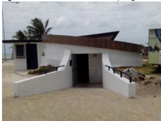
Figura 6. Vista da elevatória EE03-AS (relógio do sol)
