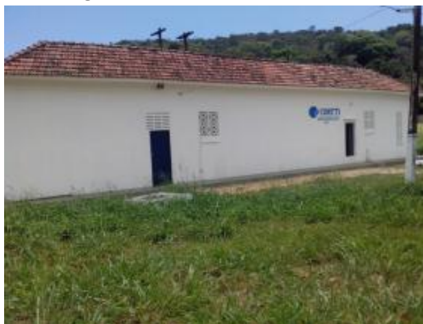
Figura 9. Vista da elevatória EE01-CS
