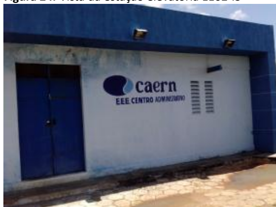
Figura 24. Vista da estação elevatória EE02-IS
