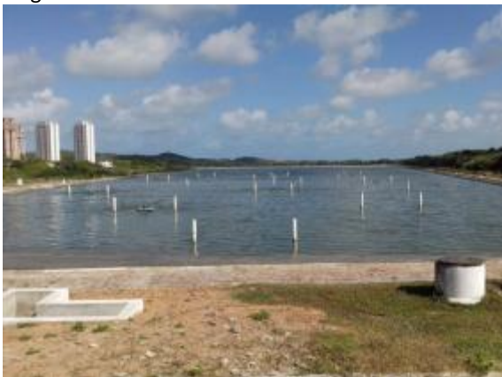
Figura 36. Vista da lagoa aerada da ETE de Ponta Negra
