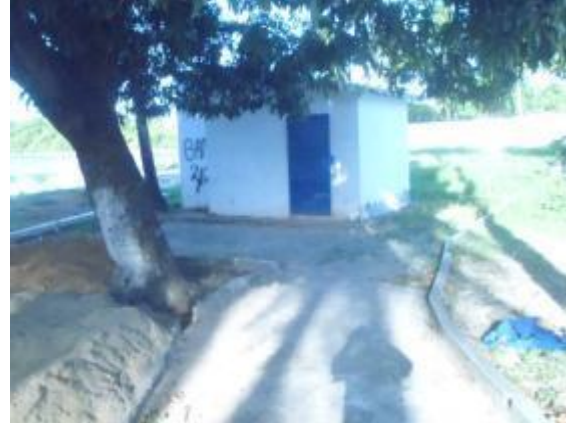
Figura 43. Vista da sala do operador da ETE Quintas II
