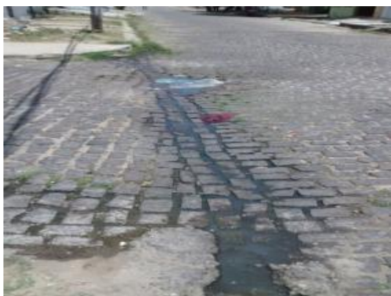
Figura 101. Esgoto a céu aberto na Zona Norte de Natal
