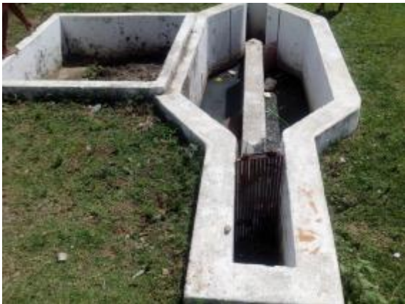
Figura 48. Vista das unidades de pré-tratamento ETE Bairro Nordeste
