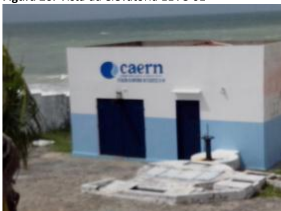
Figura 26. Vista da elevatória EEVC-01
