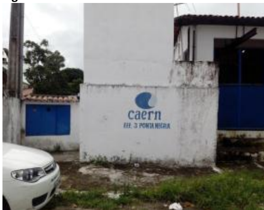
Figura 32. Vista da elevatória EE03-NS
