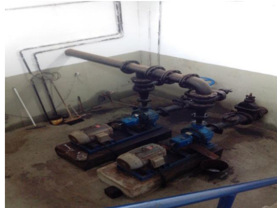
Figura 15. Vista das bombas da elevatória EE02-GS (D11)
