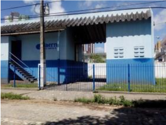
Figura 18. Vista da estação elevatória EE02-HS
