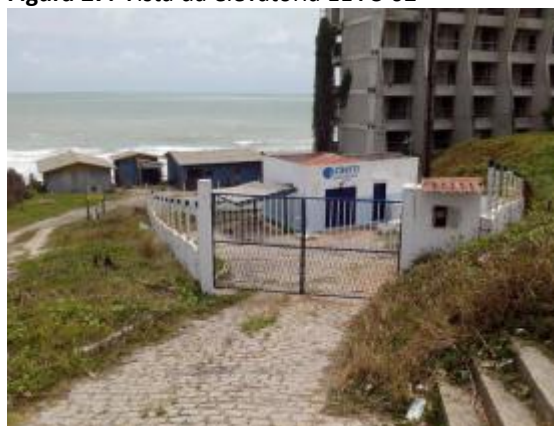
Figura 27. Vista da elevatória EEVC-02
