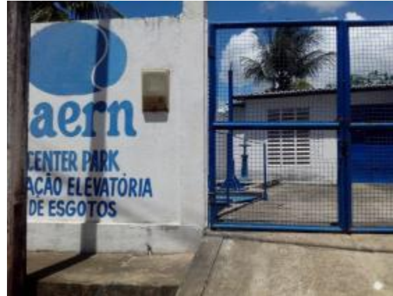
Figura 19. Vista da estação elevatória EE01-CP
