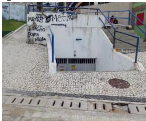
Figura 33. Vista da elevatória EE04-NS
