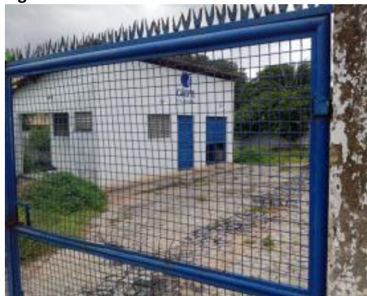
Figura 31. Vista frontal da elevatória EE02-NS
