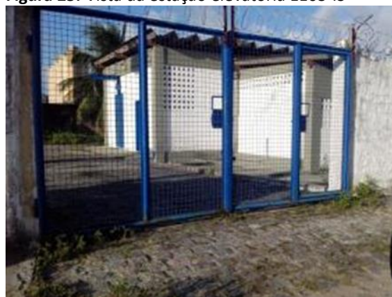
Figura 25. Vista da estação elevatória EE03-IS
