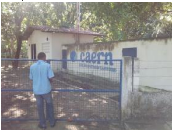
Figura 16. Vista da elevatória EE03-GS (Parque das Dunas)
