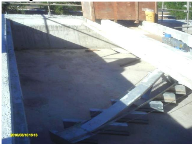
Figura 61. Vista da caixa de areia mecanizada
