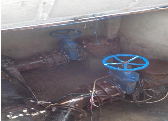
Figura 12. Vista do barrilete da elevatória EE01-GS
