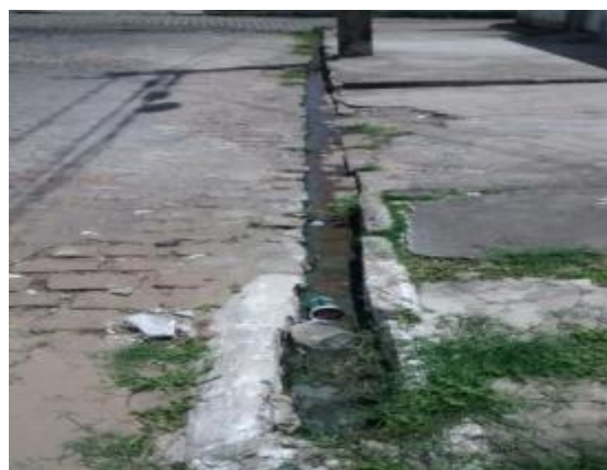
Figura 102. Esgoto a céu aberto na Zona Norte de Natal
