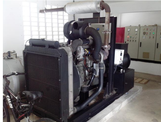
Figura 13. Vista do gerador da elevatória EE01-GS
