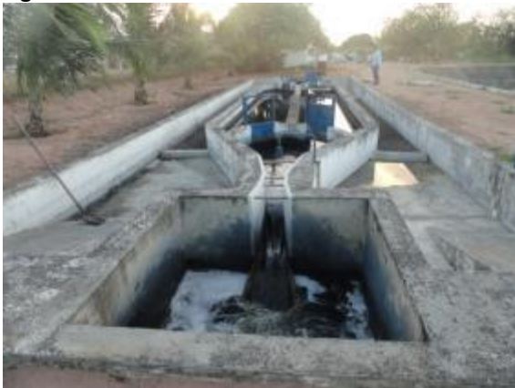
Figura 73. Vista do Pré-tratamento do SITEL do DIN
