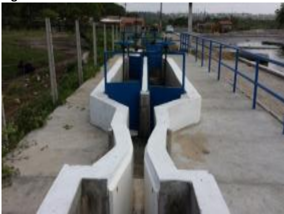
Figura 69. Pré-tratamento da ETE Beira Rio
