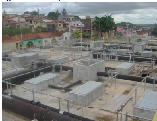
Figura 62. Vista Superior dos reatores UASB's
