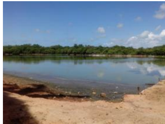
Figura 45. Vista da lagoa de estabilização da ETE Quintas II
