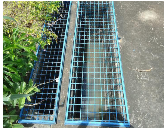
Figura 55. Vista superior do Tanque Imhoff
