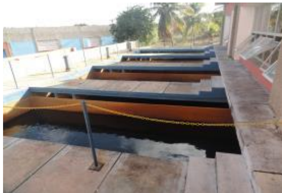
Figura 27. Vistas dos Filtros da ETA do Jiqui
