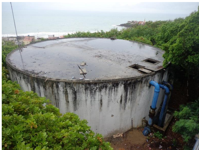
Figura 40. Vista do Reservatório R2 – Ladeira Sol
