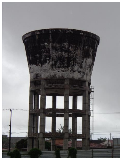
Figura 54. Vista do Reservatório R6 elevado - Candelária.
