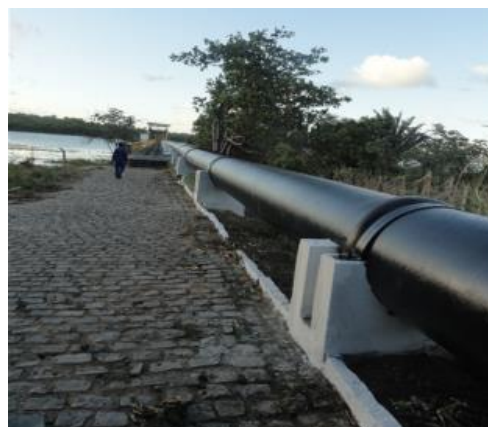
Figura 91. Adutora de água bruta – Lagoa a ETA de Extremoz
