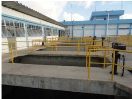
Figura 94. Unidades de filtração – ETA Extremoz
