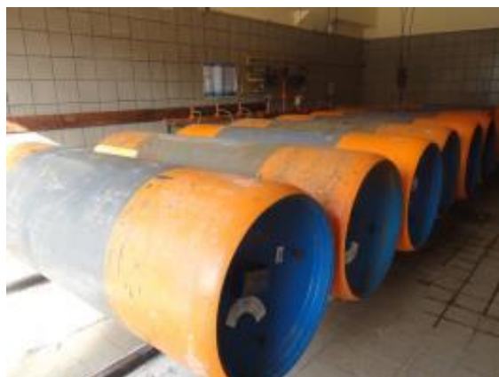
Figura 26. Sala de cilindros de cloro vendo-se ao fundo o manifold dos cloradores
