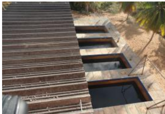
Figura 28. Vistas dos Filtros da ETA do Jiqui
