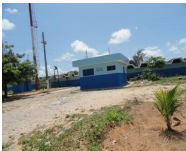
Figura 53. Vista do Reservatório R6 apoiado-Candelária.
