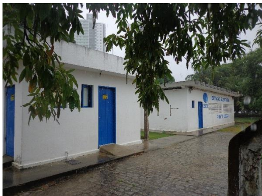
Figura 72. Estação Elevatória – Ponta Negra
