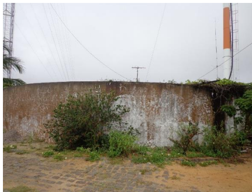
Figura 38. Vista do Reservatório R7 – Mãe Luiza
