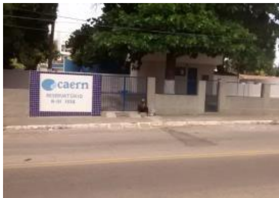
Figura 37. Vista do Reservatório R1
