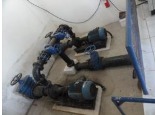
Figura 106. Elevatória que aduz água à Zona 16 - Sistema Rio Doce
