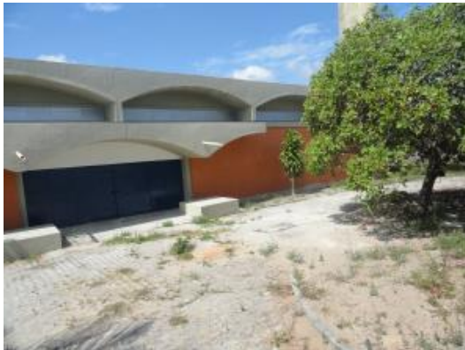
Figura 103. Reservatório R8 – Próximo da Av. João Medeiros
