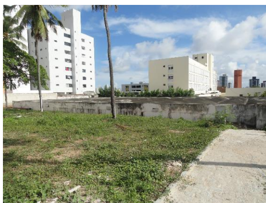
Figura 46. Vista do Reservatório R3.3 - Tirol
