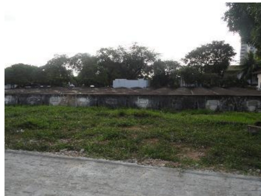
Figura 36. Reservatório R3.1 – Fachada posterior
