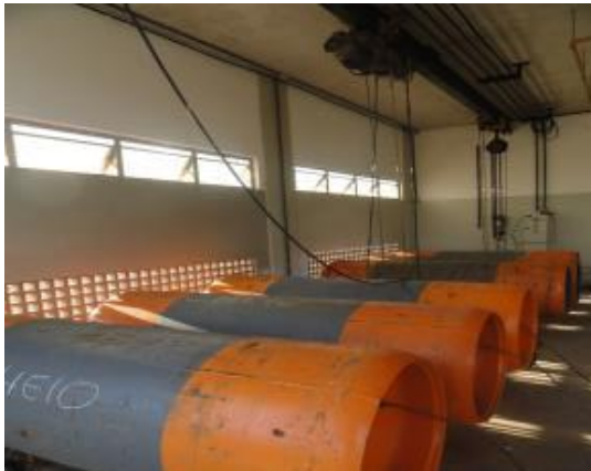
Figura 96. Posto de cloração – ETA de Extremoz
