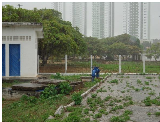
Figura 71. Poço P-7 – Ponta Negra
