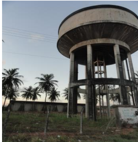
Figura 98. Centro de Reservação R14 – Parque dos Coqueiros
