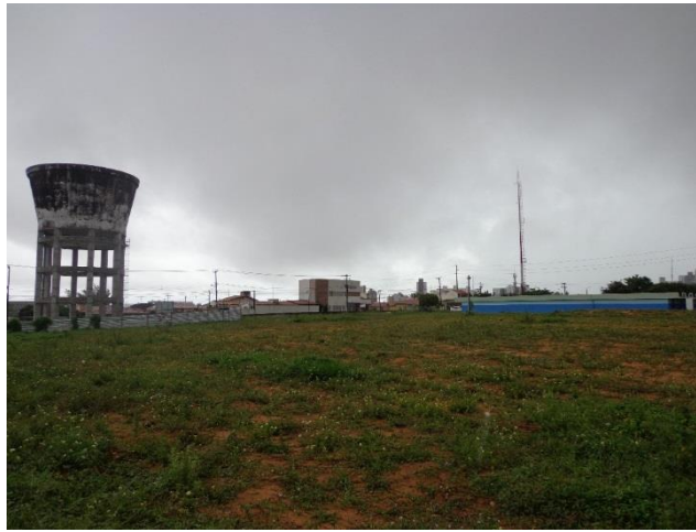
Figura 55. Centro de Reservação R6, reservatórios apoiado e elevado- Candelária.
