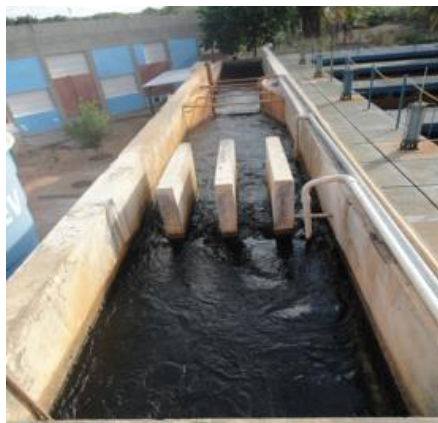
Figura 23. Calha Parshall da ETA do Jiqui
