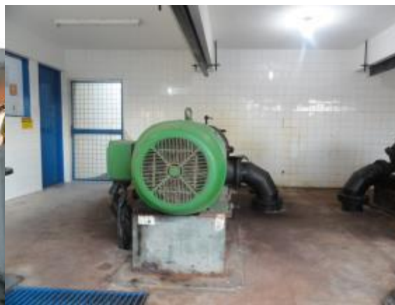
Figura 65. Detalhe Elevatória Sistema Lagoa Nova II – RNS, proximidades do Campus UFRN
