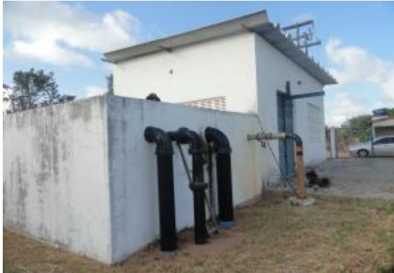
Figura 105. Entrada água de poços no tanque de reunião – Sistema Rio Doce os
