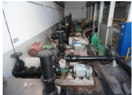
Figura 95. Elevatória de água tratada – ETA de Extremoz
