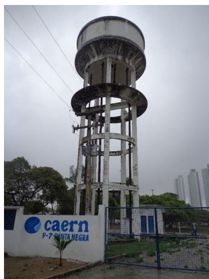
Figura 74. Reservatório R10T1 – Ponta Negra
