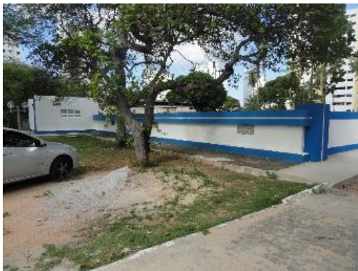
Figura 35. Reservatório R3.1 – Fachada principal e lateral
