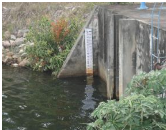
Figura 20. Tomada da captação de água bruta na Lagoa do Jiqui
