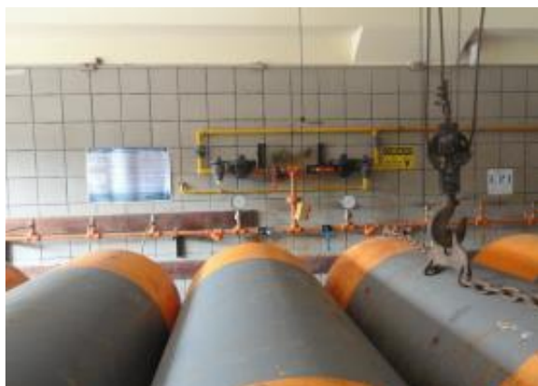
Figura 25. Sala de cilindros de cloro vendo-se ao fundo o manifold dos cloradores
