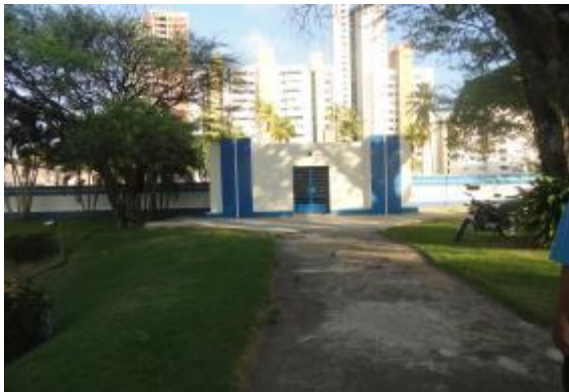
Figura 33. Vista do Reservatório R3.1 - Tirol
