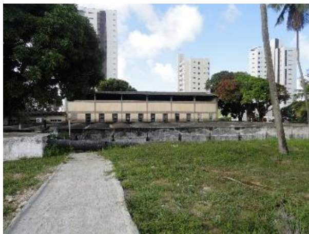
Figura 39. Vista do Reservatório R3.2 - Tirol
