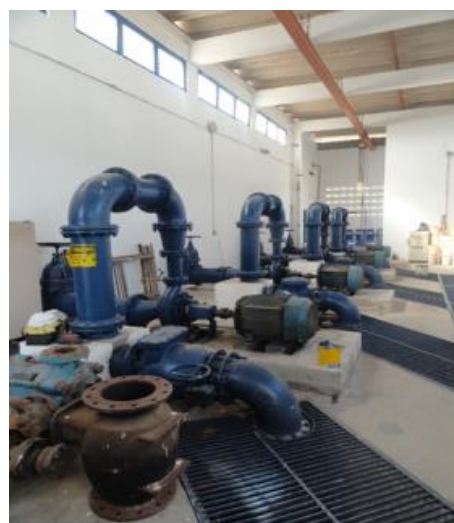
Figura 101. Elevatória da Z-16- Conj. Pajuçara
