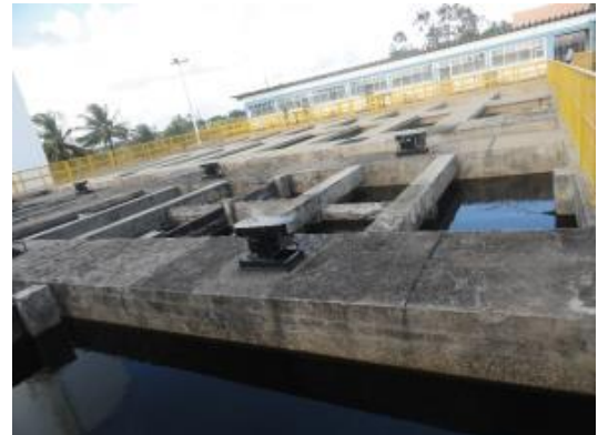
Figura 93. Unidades de floculação e decantação – ETA Extremoz
