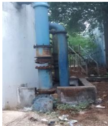
Figura 41. Tubulações de entrada e saída do Reservatório R2 – Ladeira Sol
