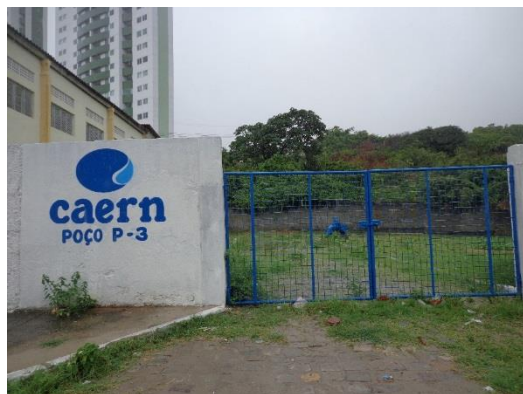
Figura 70. Poço P-3 – Ponta Negra
