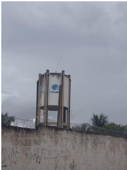
Figura 85. Reservatório elevado R9 – Felipe Camarão
