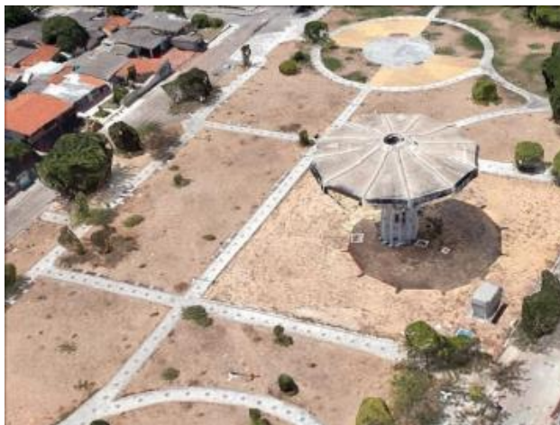
Figura 75. Reservatório R10T2 – Ponta Negra
