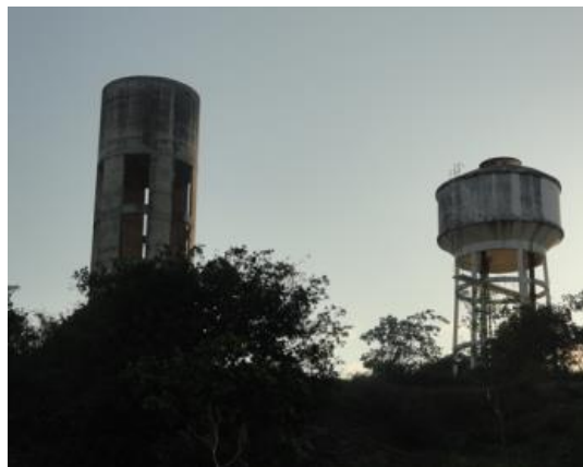
Figura 69. Reservatório R11T1 e R11T2 – Conjunto Pirangi
