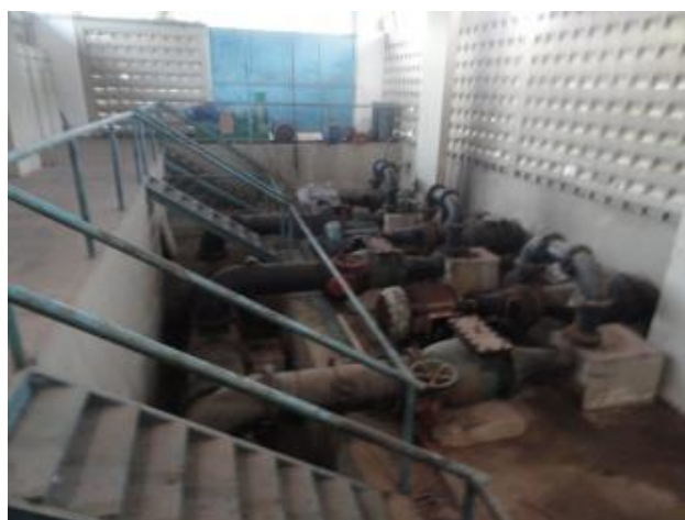
Figura 99. Estação Elevatória do R14 – Parque dos Coqueiros
