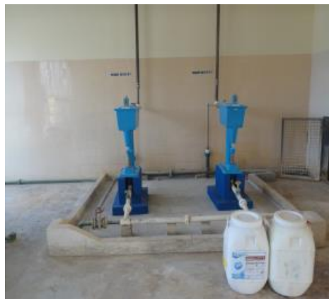
Figura 24. Dosadores de Coagulante
