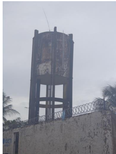
Figura 86. Reservatório elevado R9 – Felipe Camarão
