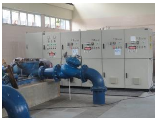
Figura 30. EEAT3 – ETA do Jiqui
