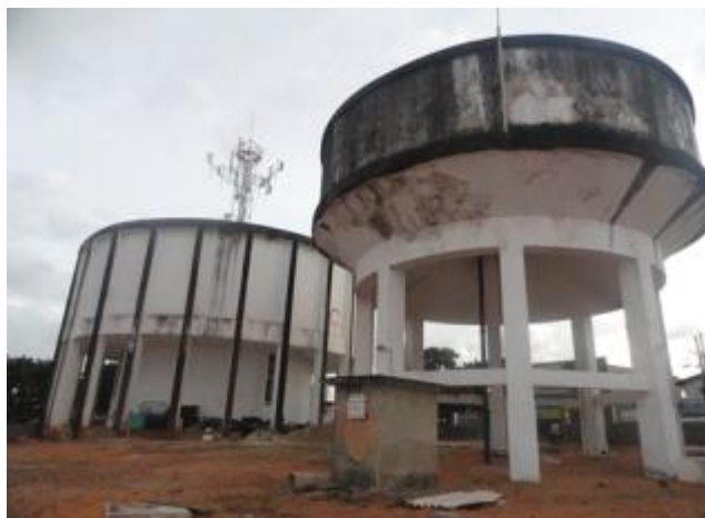
Figura 61. Reservatórios R4T1 e R4T2 – Av. Interventor Mário Câmara
