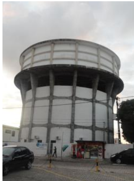
Figura 67. Reservatório R5T2 – Av. Miguel Castro do Centro de Reservação R5.
