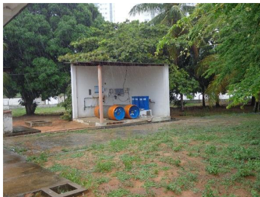
Figura 73. Sistema de cloração – Ponta Negra
