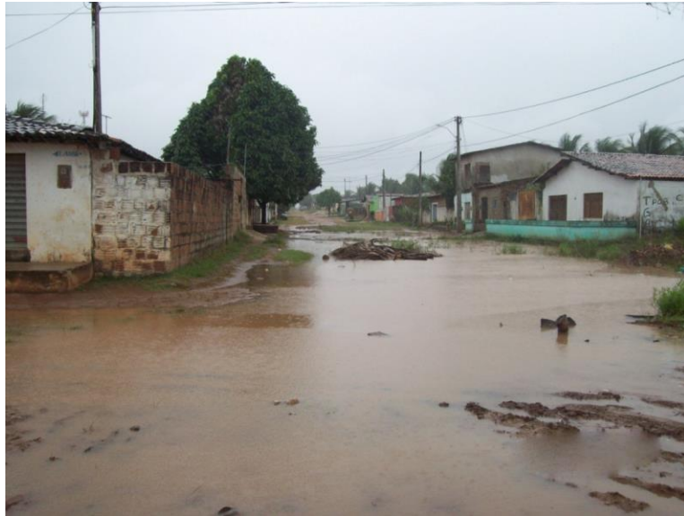
Figura 41. Foto da Avenida Nila Jales (Boa Esperança) com problemas de alagamento.
