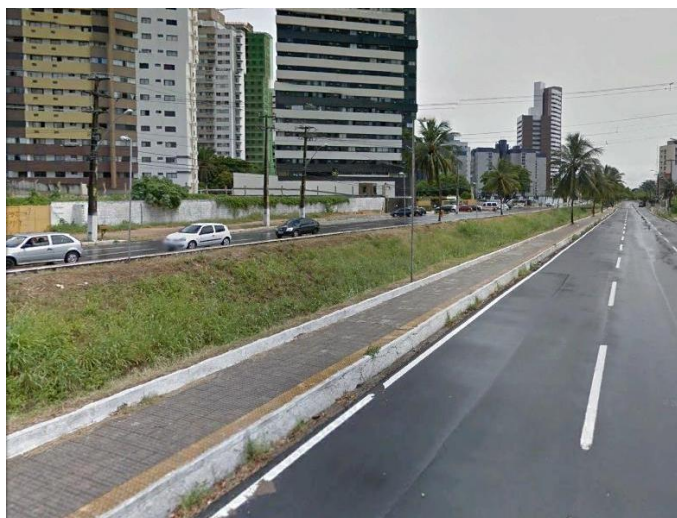
Figura 20. Canal do Baldo
