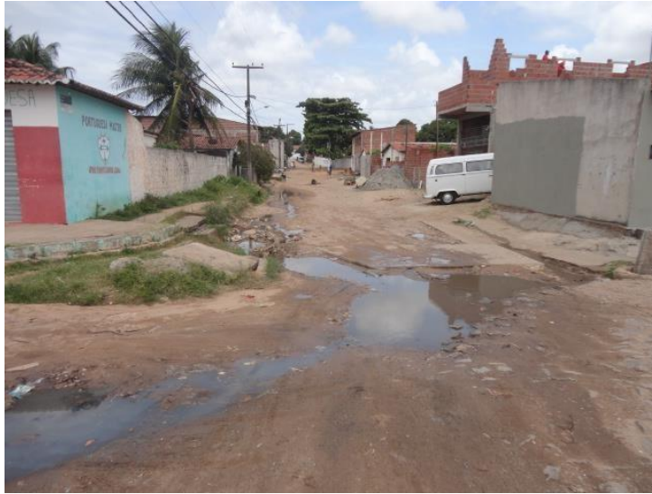
Figura 43. Foto de Rua alagada do Loteamento José Sarney.
