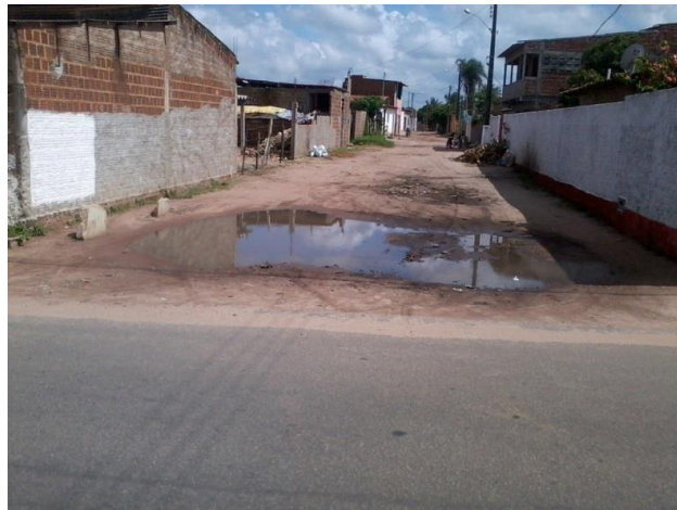
Figura 36. Foto da Rua Seis de Outubro com problemas de alagamento.
