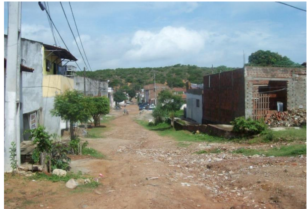
Figura 51. Rua com problema de drenagem e sem pavimentação (Bairro Planalto).
