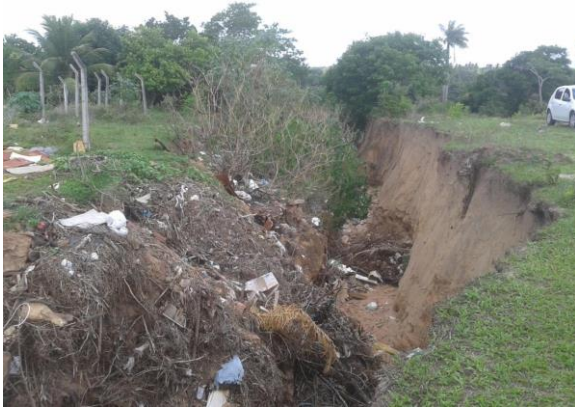
Figura 50. Rua com problema de drenagem e sem pavimentação (Bairro Planalto).
