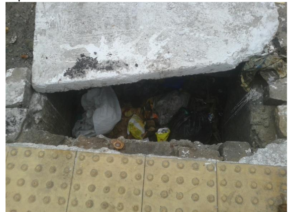
Figura 63. Boca de Lobo totalmente tomada pelo lixo.
