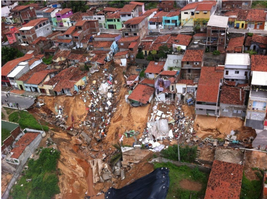
Figura 65. Erosão da Rua Guanabara (Desmonte Hidráulico).
