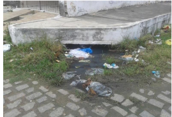
Figura 61. Boca de Lobo com esgoto, obstruída e danificada
