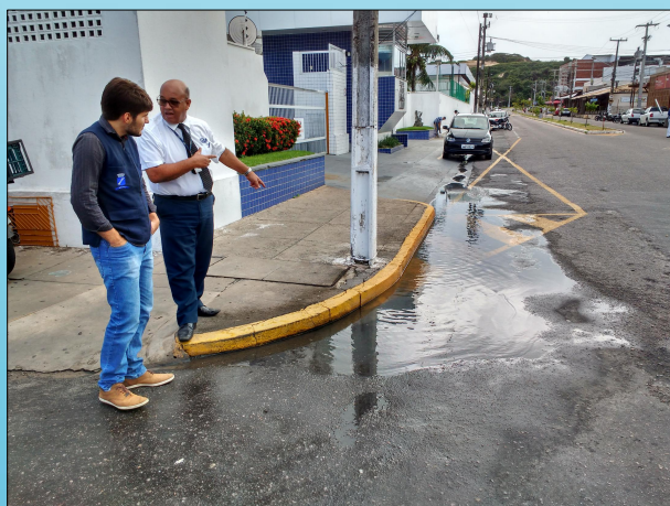
Fiscalização de esgotamento sanitário em Ponta Negra (Junho/2017)
