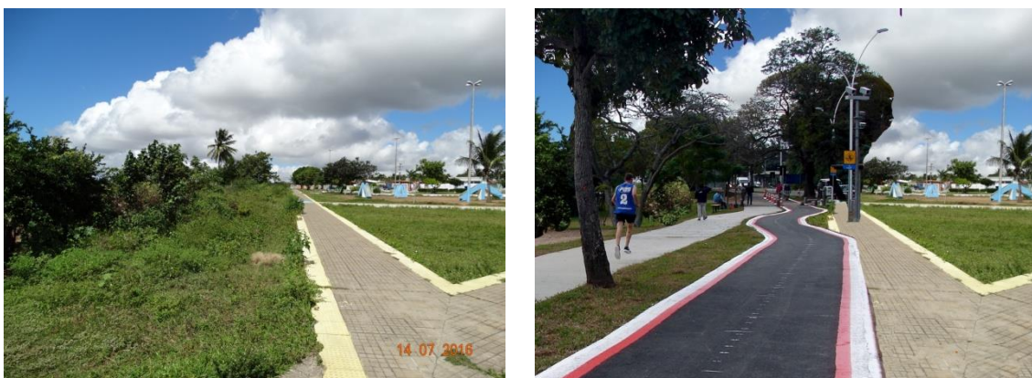
Figura 11 – Concepção inicial via de contorno da Subzona de Preservação no Setor A da ZPA 8
