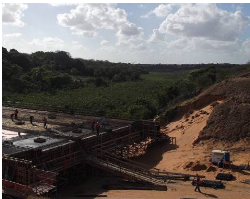
Ilustrações 21 e 22 - Obras de extensão da Av. Prudente Moraes dentro da ZPA-3; construção de ponte sobre o Rio Pitimbú, com corte de dunas junto ao leito do rio.
