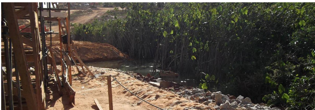
Ilustrações 23, 24 e 25 - Obras de extensão da Av. Prudente Moraes dentro da ZPA-3; estreitamento da caixa do Rio Pitimbú para execução dos apoios da ponte sobre o rio.
