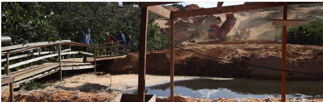
Ilustrações 21 e 22 - Obras de extensão da Av. Prudente Moraes dentro da ZPA-3; construção de ponte sobre o Rio Pitimbú, com corte de dunas junto ao leito do rio.
