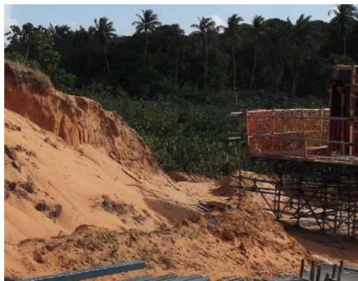
Ilustrações 21 e 22 - Obras de extensão da Av. Prudente Moraes dentro da ZPA-3; construção de ponte sobre o Rio Pitimbú, com corte de dunas junto ao leito do rio.
