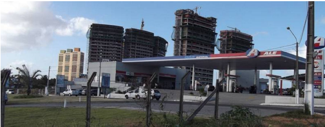
Ilustração 6 - Empreendimentos imobiliários em construção na Av. Senador Salgado Filho, BR-101, esquina com Av. dos Caiapós, a montante do limite da ZPA-3.
