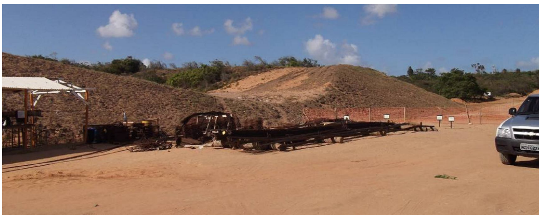
Ilustrações 18, 19 e 20 - Obras de extensão da Av. Prudente Moraes dentro da ZPA-3, sobre dunas no tabuleiro costeiro.
