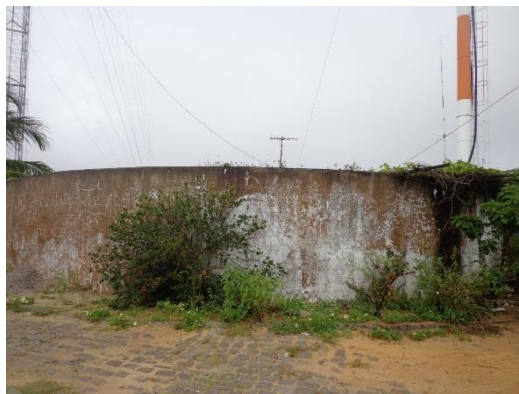
Figura 38. Vista do Reservatório R7 – Mãe Luiza
