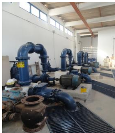
Figura 101. Elevatória da Z-16- Conj. Pajuçara
