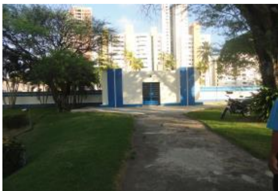
Figura 33. Vista do Reservatório R3.1 - Tirol
