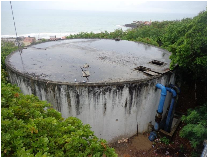
Figura 40. Vista do Reservatório R2 – Ladeira Sol
