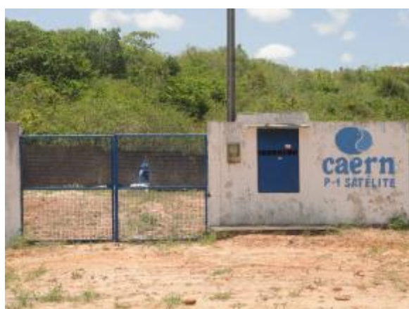
Figura 80. Poço P01- Cidade Satélite
