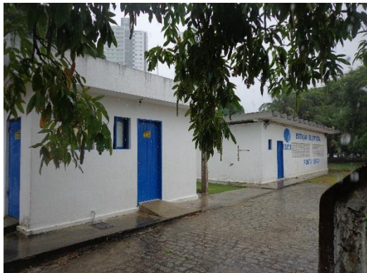
Figura 72. Estação Elevatória – Ponta Negra
