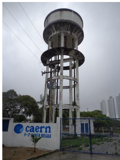
Figura 74. Reservatório R10T1 – Ponta Negra
