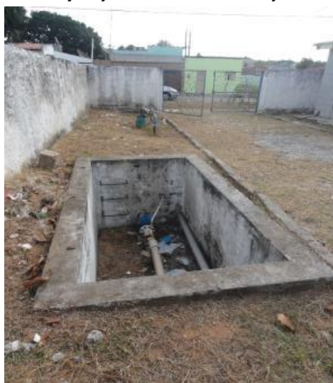
Figura 102. Poço injetando na rede – Conjunto Gramoré
