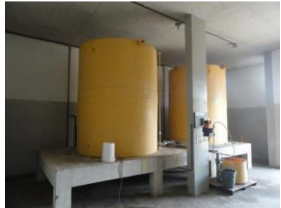
Figura 97. Tanques de solução de PAC – ETA de Extremoz
