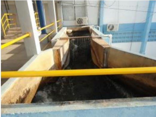
Figura 92. Canal da calha Parshall e aplicação de coagulantes – ETA Extremoz
