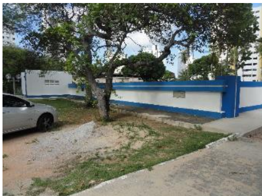
Figura 35. Reservatório R3.1 – Fachada principal e lateral
