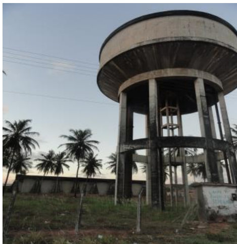
Figura 98. Centro de Reservação R14 – Parque dos Coqueiros
