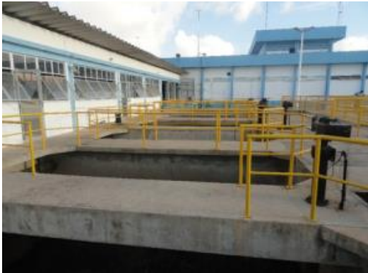
Figura 94. Unidades de filtração – ETA Extremoz
