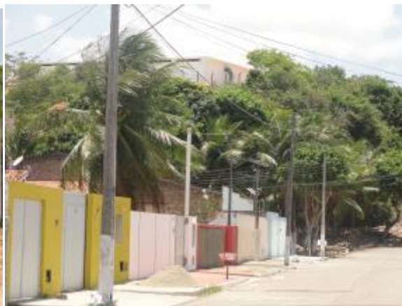
Figura 81. Reservatório apoiado R12 – Cidade Satélite
