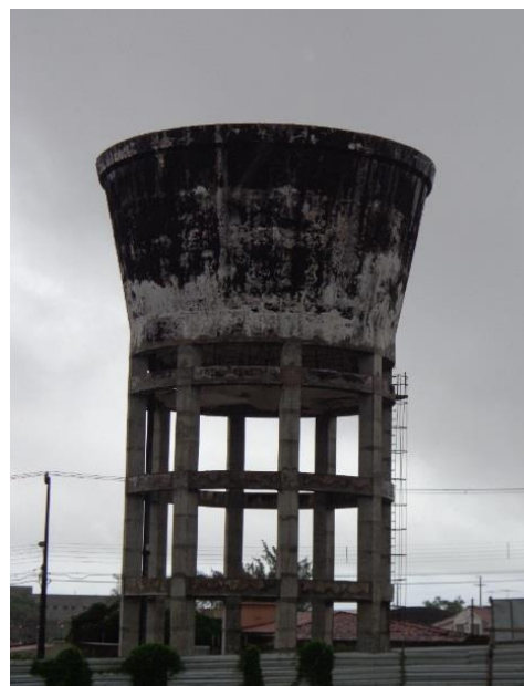
Figura 54. Vista do Reservatório R6 elevado - Candelária.
