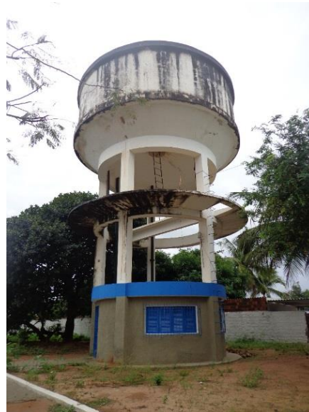
Figura 87. Vista do Reservatório R13 - Guarapes
