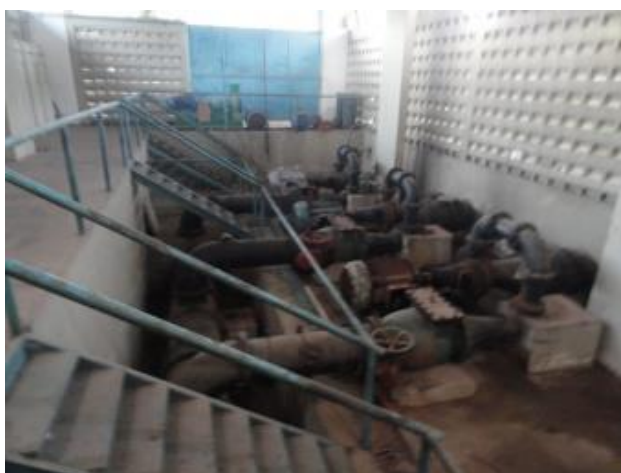
Figura 99. Estação Elevatória do R14 – Parque dos Coqueiros
