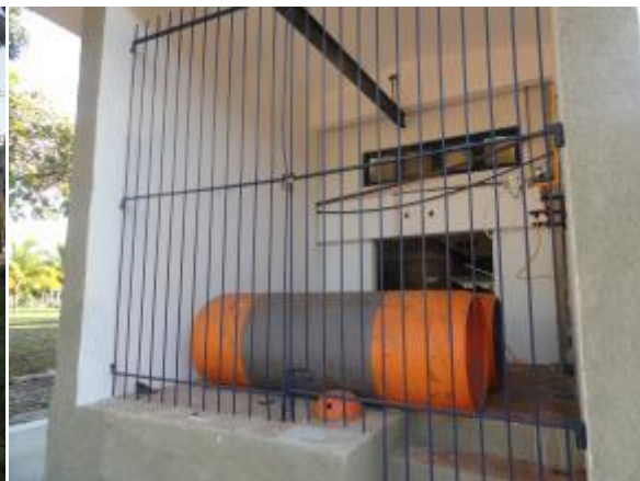
Figura 60. Posto cloração Sistema Lagoa Nova I – Centro Administrativo
