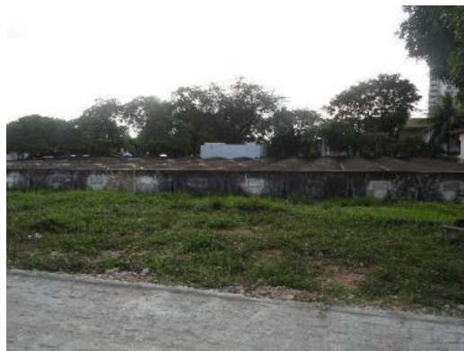
Figura 36. Reservatório R3.1 – Fachada posterior
