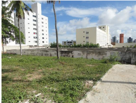
Figura 46. Vista do Reservatório R3.3 - Tirol
