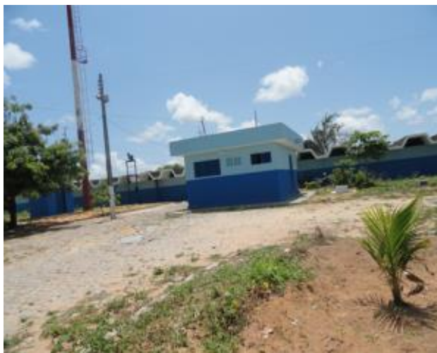
Figura 53. Vista do Reservatório R6 apoiado- Candelária.
