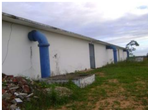
Figura 84. Reservatório R12- Cidade Satélite
