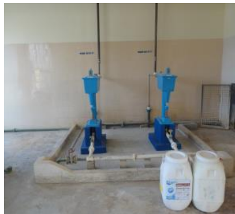
Figura 24. Dosadores de Coagulante
