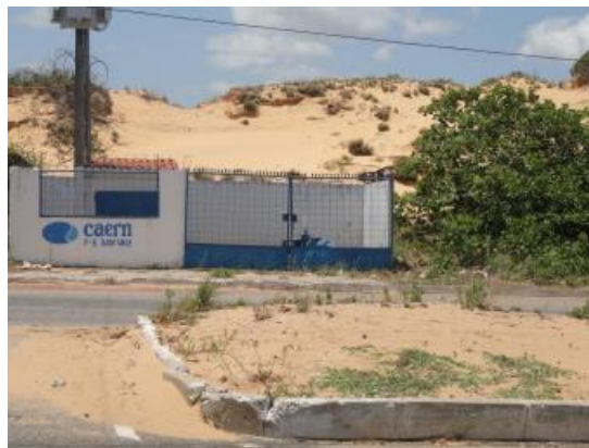
Figura 57. Poço P06 – San Valle (Prolongamento da Av. Prudente de Moraes)
