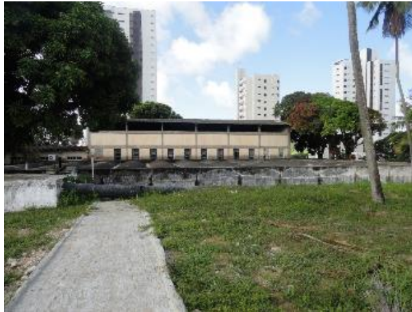
Figura 39. Vista do Reservatório R3.2 - Tirol
