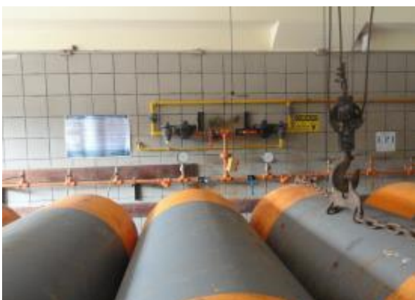
Figura 25. Sala de cilindros de cloro vendo-se ao fundo o manifold dos cloradores
