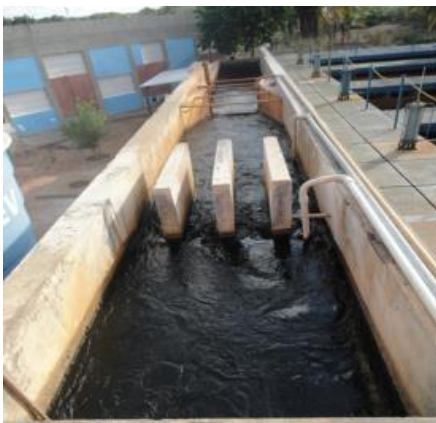
Figura 23. Calha Parshall da ETA do Jiqui
