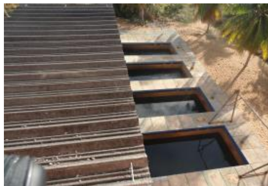
Figura 28. Vistas dos Filtros da ETA do Jiqui
