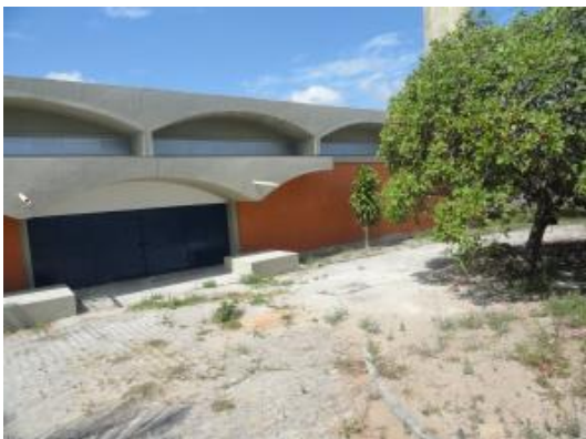
Figura 103. Reservatório R8 – Próximo da Av. João Medeiros
