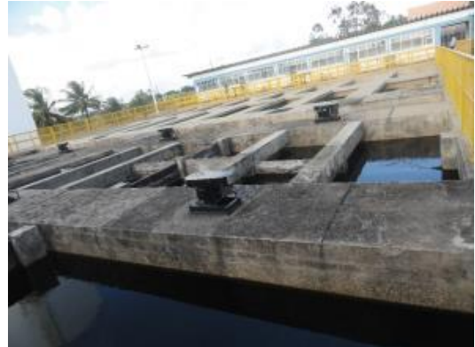
Figura 93. Unidades de floculação e decantação – ETA Extremoz
