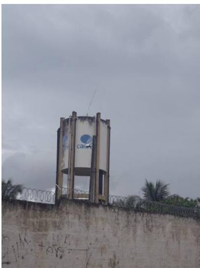
Figura 85. Reservatório elevado R9 – Felipe Camarão
