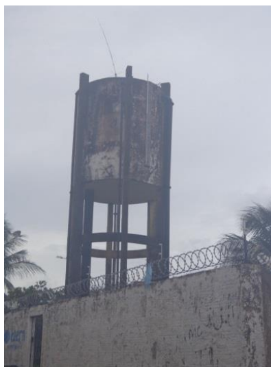
Figura 86. Reservatório elevado R9 – Felipe Camarão
