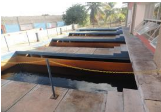
Figura 27. Vistas dos Filtros da ETA do Jiqui
