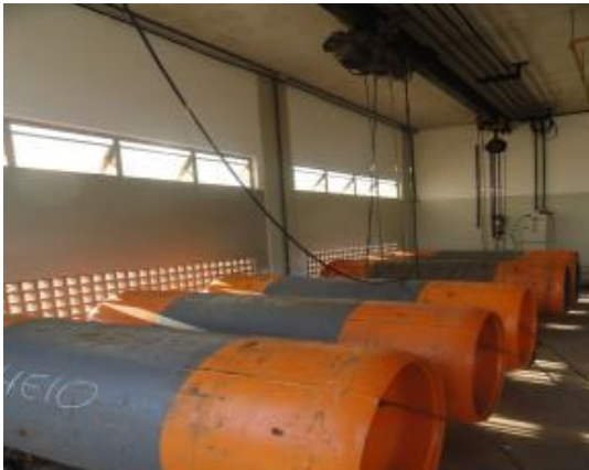
Figura 96. Posto de cloração – ETA de Extremoz
