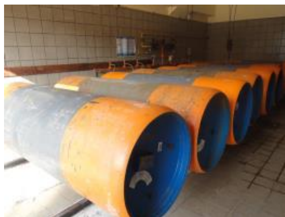
Figura 26. Sala de cilindros de cloro vendo-se ao fundo o manifold dos cloradores
