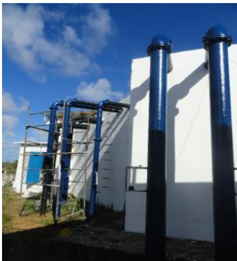
Figura 100. Entrada dos poços no reservatório da Z-16 – Conj. Pajuçara
