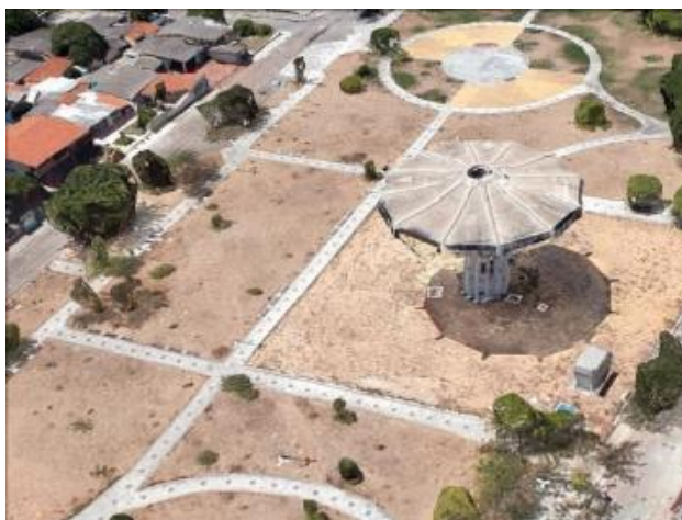
Figura 75. Reservatório R10T2 – Ponta Negra
