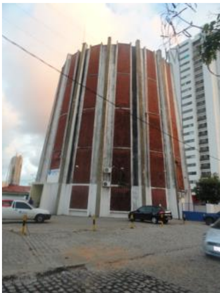
Figura 66. Reservatório R5T1 – Av. Miguel Castro do Centro de Reservação R5.
