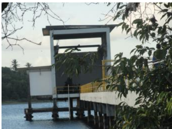
Figura 90. Captação de água bruta na Lagoa de Extremoz- Extremoz
