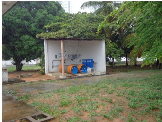
Figura 73. Sistema de cloração – Ponta Negra
