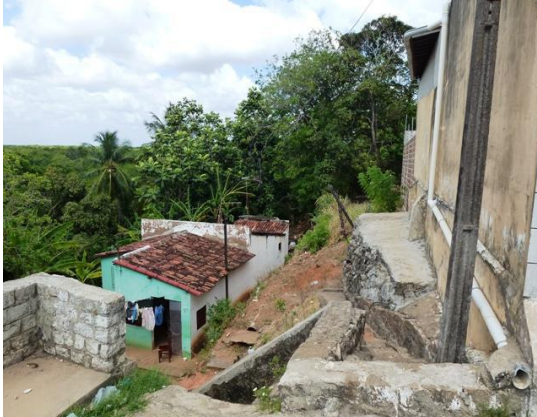
Figura 42. Erosão em vertentes de tabuleiro da ZPA-08 com alto risco e intenso processo erosivo já instalado
