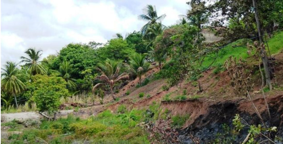
Figura 45. Erosão em vertentes de tabuleiro da ZPA-08 com alto risco e intenso processo erosivo já instalado
