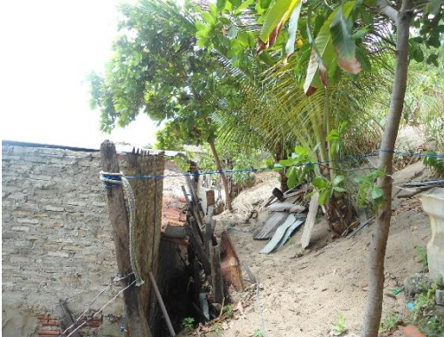
Figura 22. Vista parcial dos fundos da residência de nº 304, onde se observa a forte inclinação dos vegetais, indícios de movimento de massa do tipo rastejo
