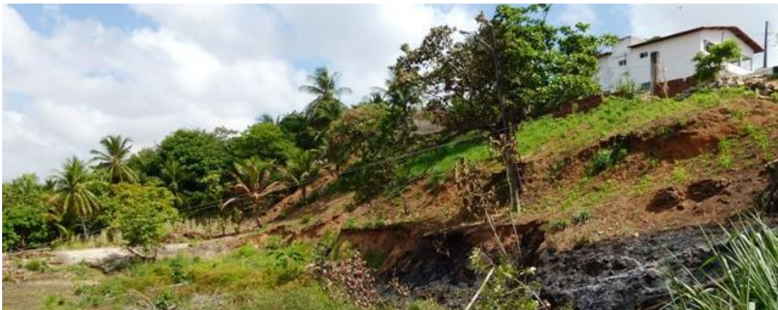
Figura 44. Erosão em vertentes de tabuleiro da ZPA-08 com alto risco e intenso processo erosivo já instalado
