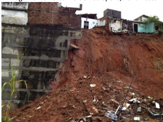
Figura 69. Colapso do muro de arrimo na comunidade do Jacó (imagem do dia 14 de Junho de 2014), Zona Leste, no bairro das Rocas. Alagamento no bairro de Petrópolis, Zona Leste.
