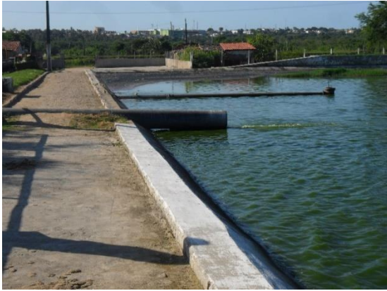
Figura 32. Carga de efluentes lançados nas lagoas da ETE do bairro Salinas, Zona Norte.
