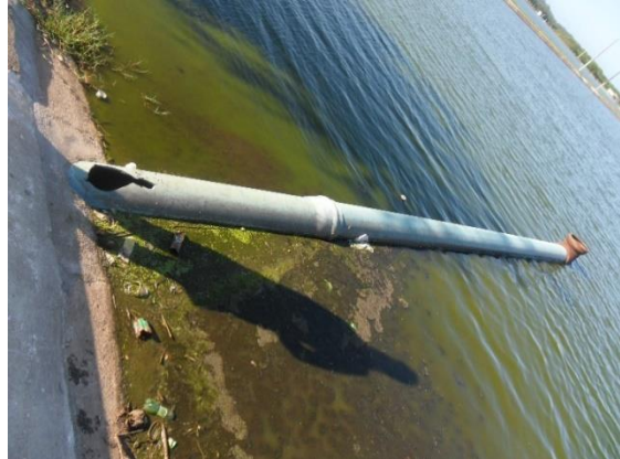
Figura 33. Estrutura de condução depreciada
