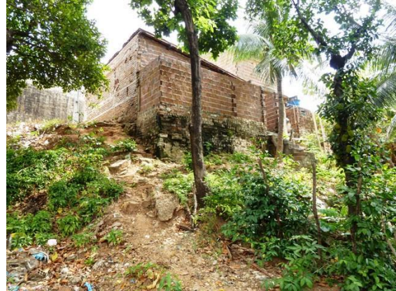
Figura 43. Erosão em vertentes de tabuleiro da ZPA-08 com alto risco e intenso processo erosivo já instalado
