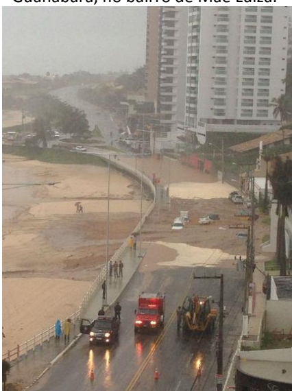
Figura 66. Imagem aérea da resultante do movimento de massa por deslizamento ocorrido na Rua Guanabara, no bairro de Mãe Luiza.
