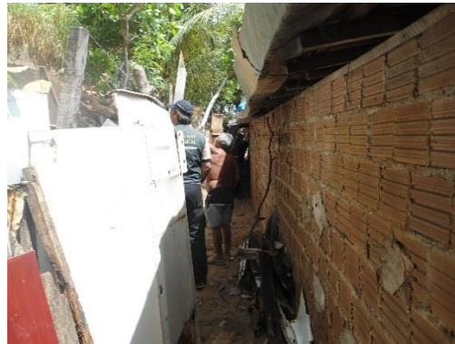
Figura 21. Acesso aos fundos da Residência de nº 304
