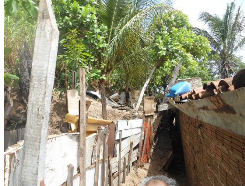
Figura 23. Vista parcial dos fundos da residência de nº 304, onde se observa a forte inclinação dos vegetais, indícios de movimento de massa do tipo rastejo
