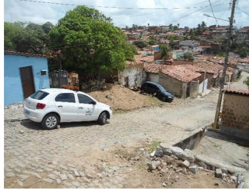
Figura 19. Residências situadas na encosta das dunas na margem direita da VIII Travessa João XXIII
