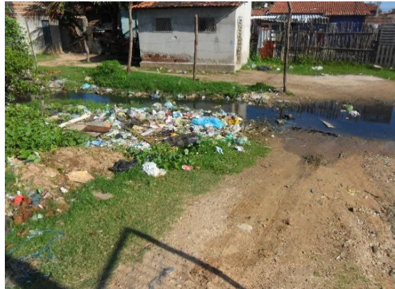
Figura 35. Deposição de resíduos em braço de rio, na entrada da ETE
