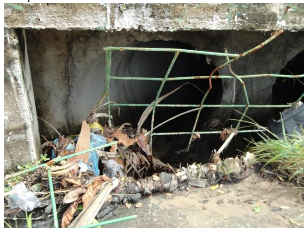
Figura 54 – Resíduos sólidos nos dispositivos de drenagem. Detalhe do gradeamento do dispositivo completamente deteriorado
