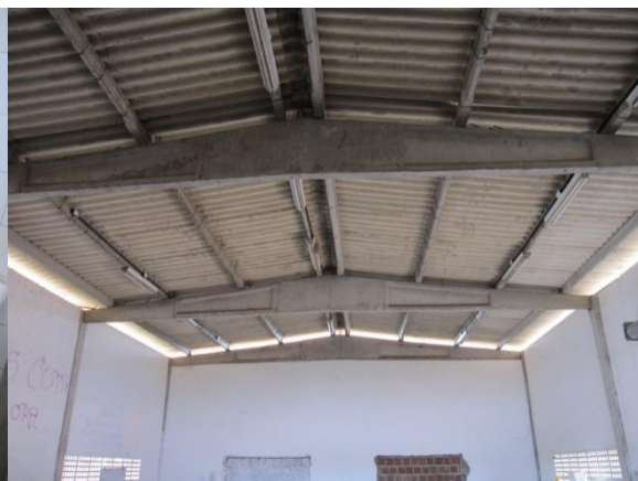
Figura 70. Estrutura do telhado e iluminação
