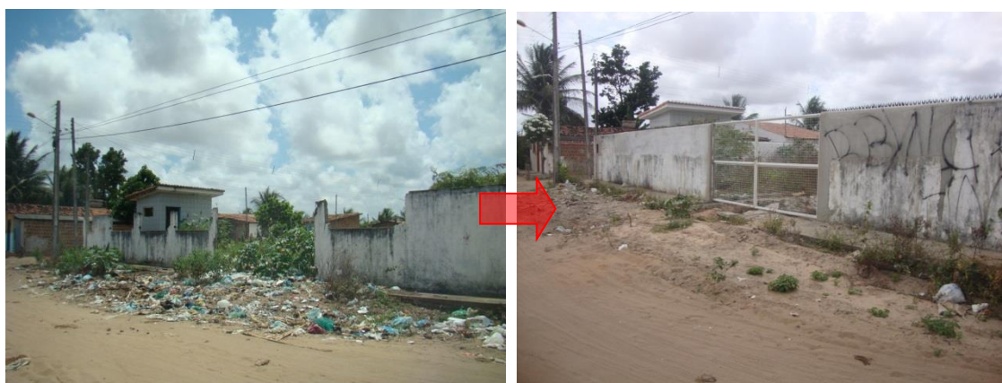
Figura 95. Extinção de Ponto de Deposição com a construção de muro
