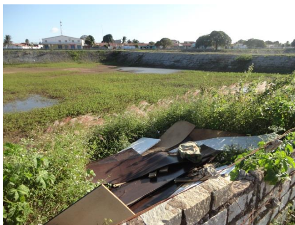
Figura 55. Lagoas de captação com vegetação e a presença de resíduos sólidos em suas margens
