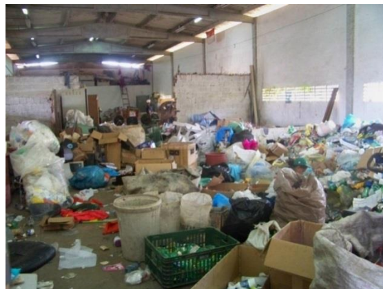
Figura 62. Estrutura interna do galpão
