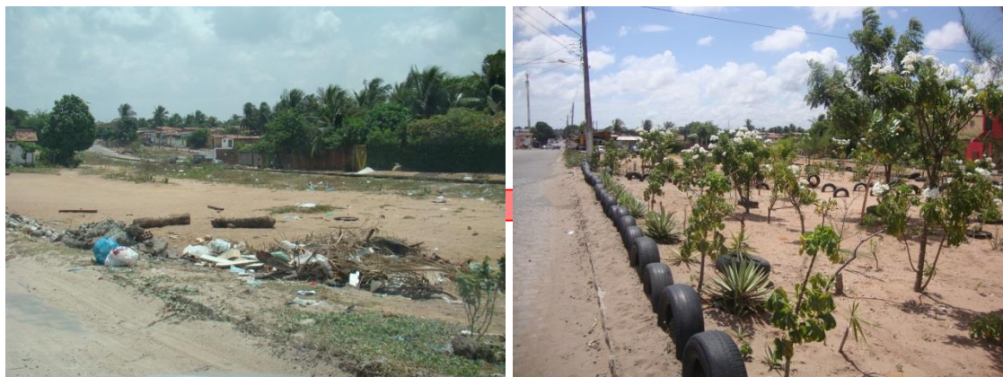
Figura 94. Extinção de Ponto de Deposição de Resíduos com plantio da área
