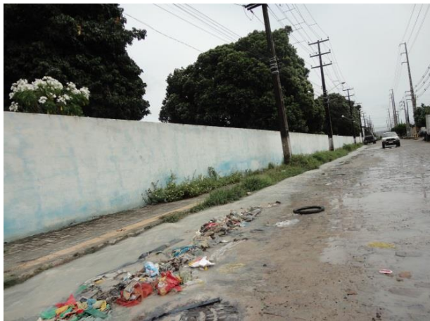
Figura 53. Grande quantidade de resíduos sólidos sendo carreados no escoamento de água pluvial
