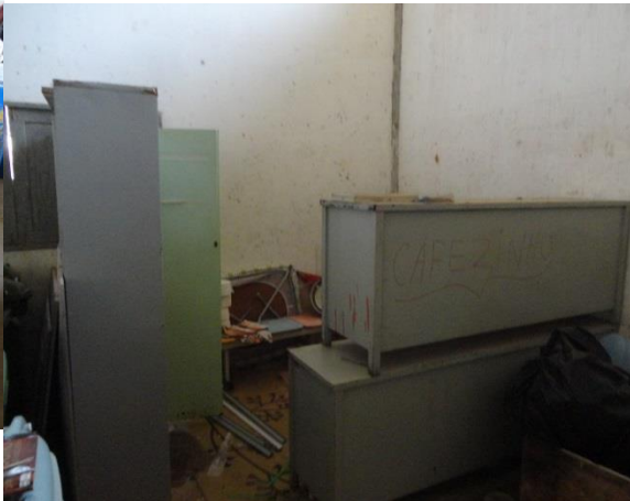
Figura 79. Vestiário improvisado, falta de estruturas físicas para o desenvolvimento do trabalho
