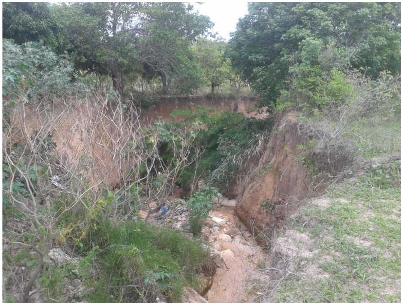
Figura 49. Processo Erosivo da Rua São Bráulio para o Rio Pitimbu (Bairro Planalto).
