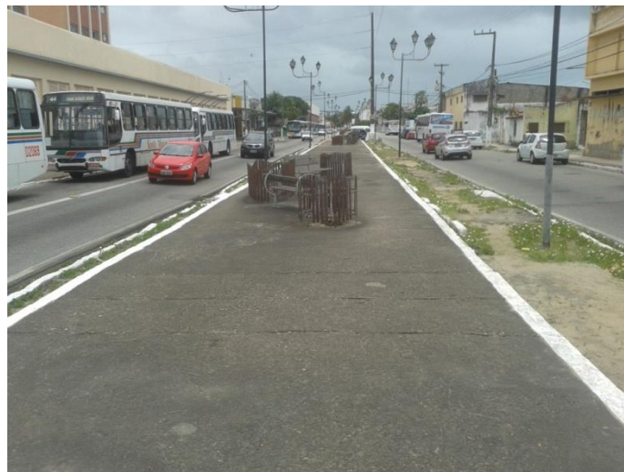
Figura 62. Canal a ser desobstruído e recuperado.
