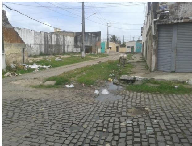
Figura 60. Rua com galeria obstruída e danificada.
