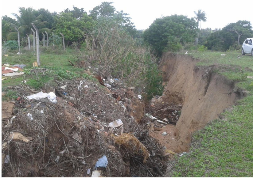
Figura 48. Processo Erosivo da Rua São Bráulio para o Rio Pitimbu (Bairro Planalto).
