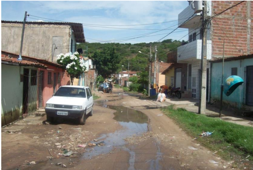
Figura 50. Rua com problema de drenagem e sem pavimentação (Bairro Planalto).
