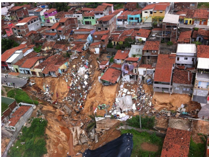
Figura 65. Erosão da Rua Guanabara (Desmonte Hidráulico).
