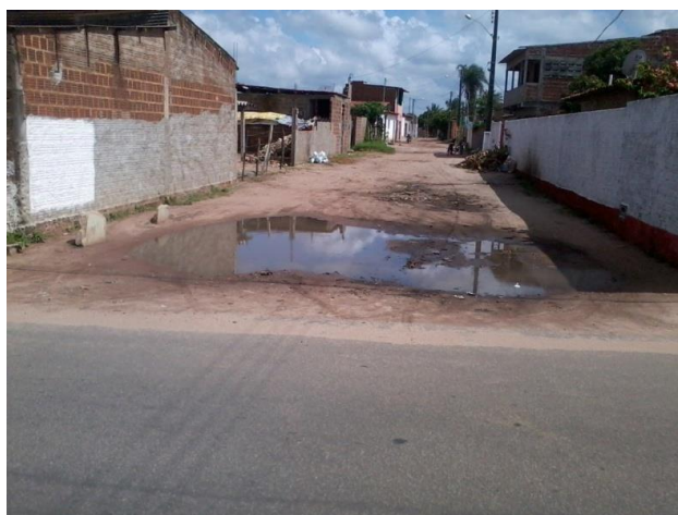
Figura 36. Foto da Rua Seis de Outubro com problemas de alagamento.
