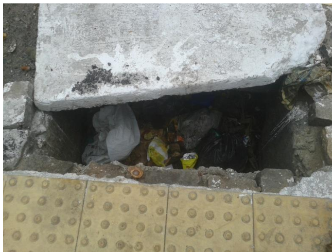
Figura 63. Boca de Lobo totalmente tomada pelo lixo.
