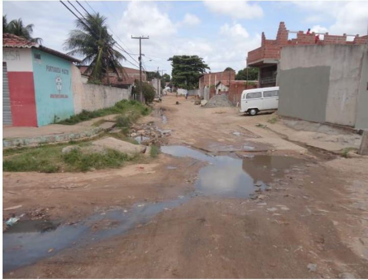
Figura 43. Foto de Rua alagada do Loteamento José Sarney.
