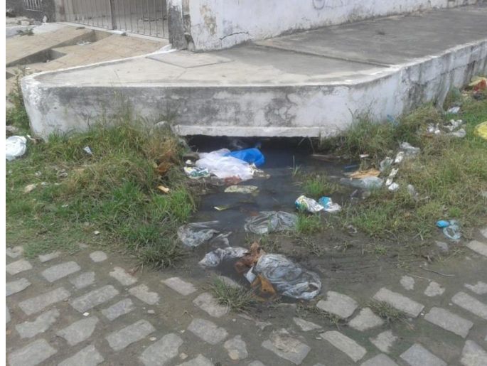
Figura 61. Boca de Lobo com esgoto, obstruída e danificada.
